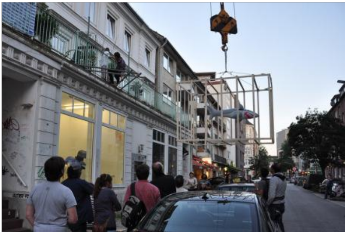
Eine eigens für das Projekt entwickelte Halterung wurde am Gebäude befestigt Foto: Géraldine et Tizian
